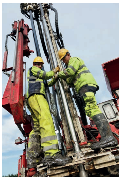
Forage des puits verticaux.
